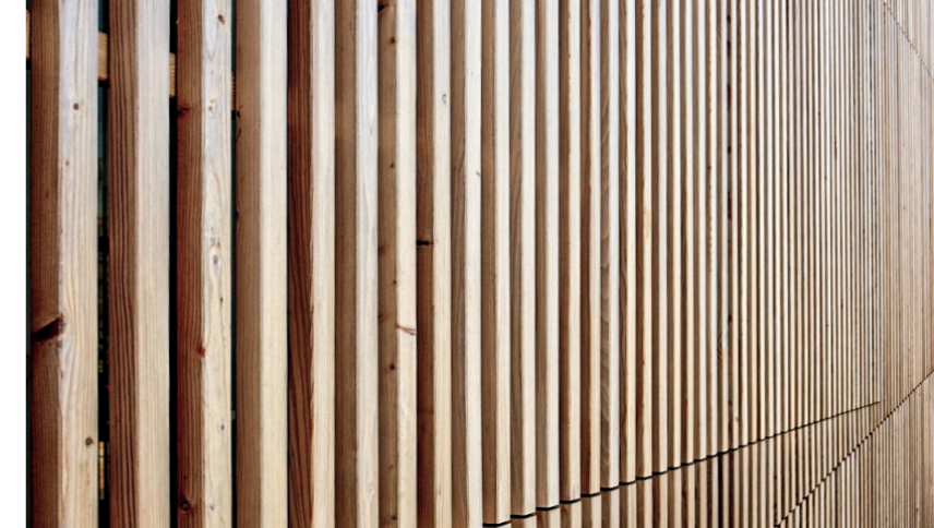
Abb. 3: Beispiel Offene Fassade aus Holz
